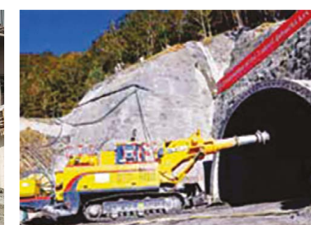
Шасси проходческой машины XCMG на строительстве тоннеля Ябука на скоростной автомагистрали «Север-Юг» в Черногории
