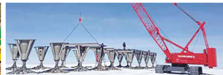
Гусеничные краны на строительстве российской антарктической научно-исследовательской станции
