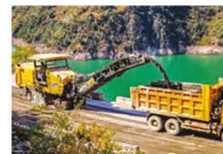
Шасси дорожной фрезы XCMG, работающей на объекте строительства в Гуйчжоу
